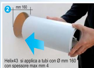
2 Helix43 si applica a tubi con Ø mm 160 con spessore max mm 4
