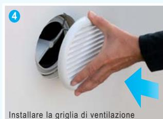
4 Installare la griglia di ventilazione
